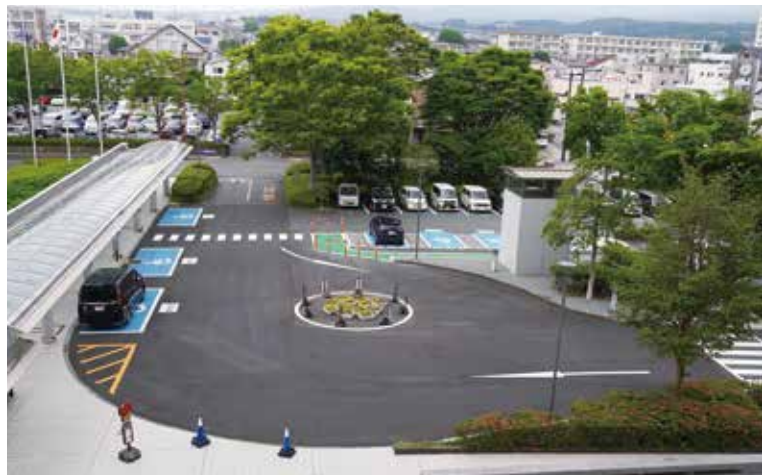
▲ロータリーを広く改良し、障がい者用駐車スペースも拡充しました。
