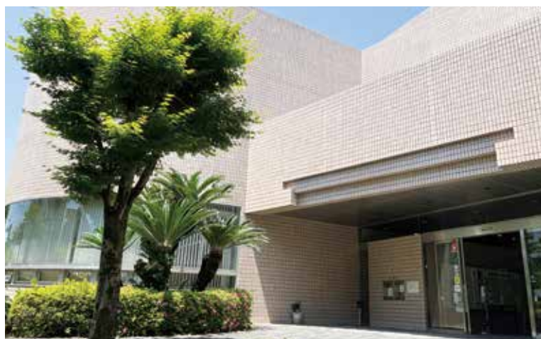
▲大規模改修を終えた中央図書館
