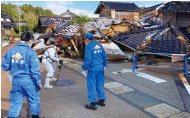
▲マンホールの蓋を開けて内部を確認
