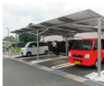
西消防署北分署 駐車場
