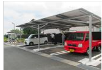
西消防署北分署 駐車場
