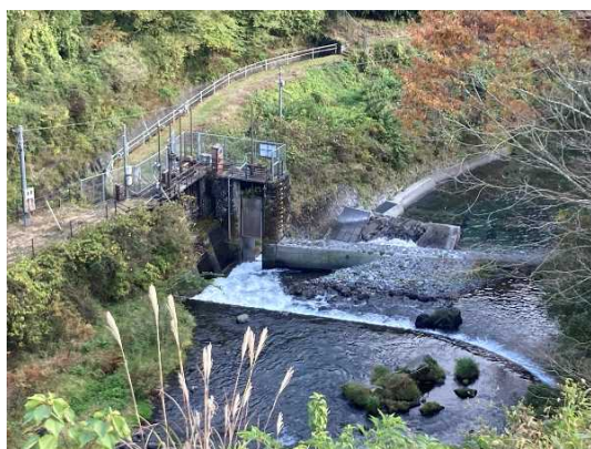
写真 3-9 狩宿発電所 第二堰堤
