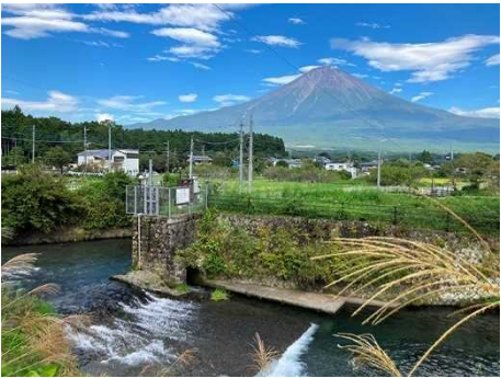
写真 2-14 白糸発電所 (堰堤・取水口)
