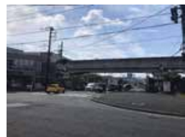
浅間大社南交差点歩道整備
