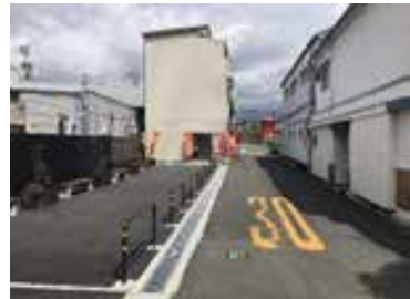
市道宮町5号線拡幅整備部
