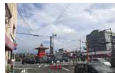
市道上空のアーケードを撤去
