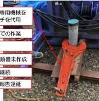
安全対策前の現場状況
