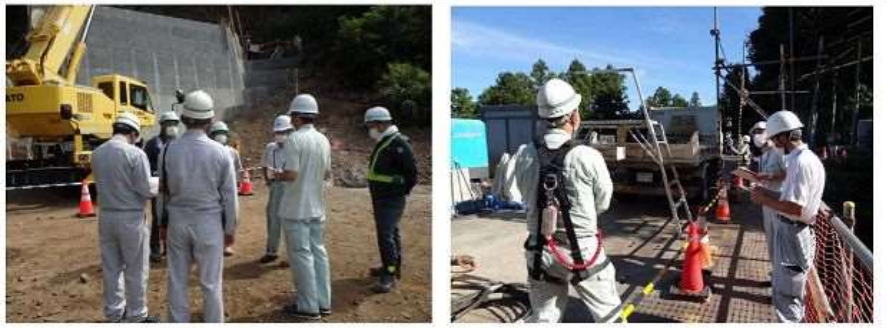
複数の監督員による現場確認状況
