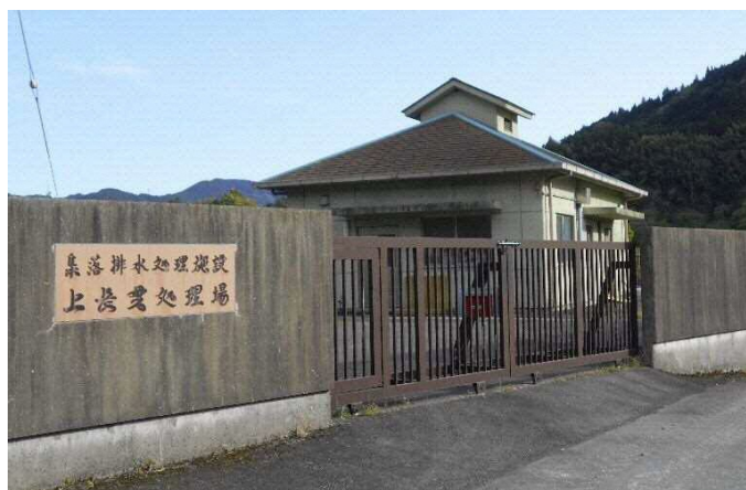
農業集落排水処理施設
