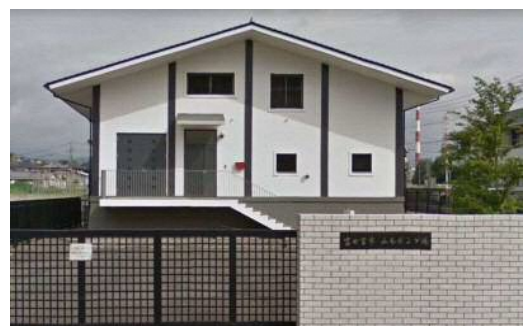
山本ポンプ場
