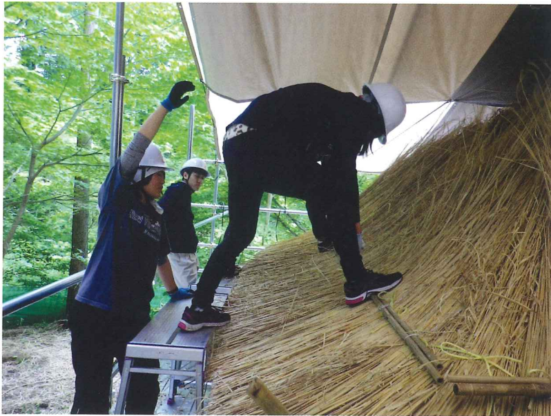
写真 6-4 押鉾竹の締め付け
