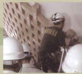
部材組み上げ
