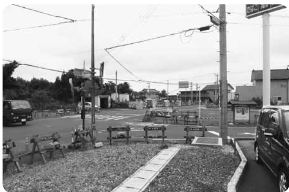
▲橋戸交差点改良の様子
