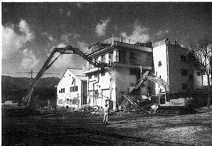
▲ 富士山総本部解体作業
