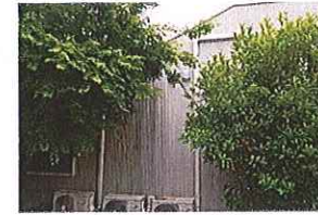
店舗外観(東側)
