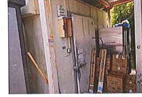
49. 店舗東冷蔵倉庫
