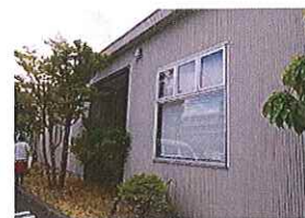
店舗外観(北側)
