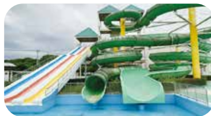
▲市民プールのスライダー
