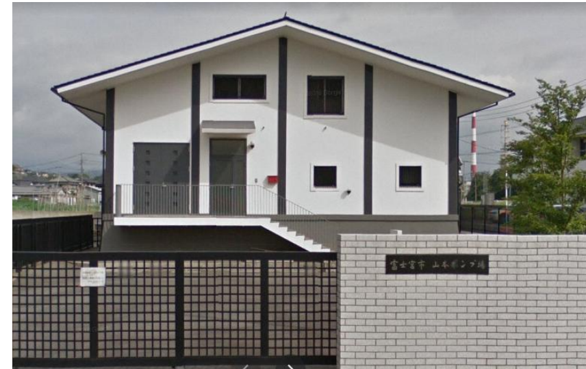
山本ポンプ場
