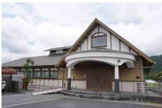
写真 2-1 猪之頭区民館
