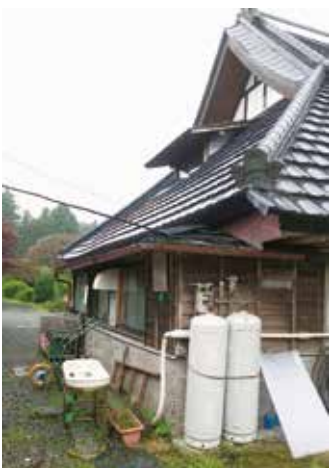
写真 3-29 東側屋根の切り上げ
