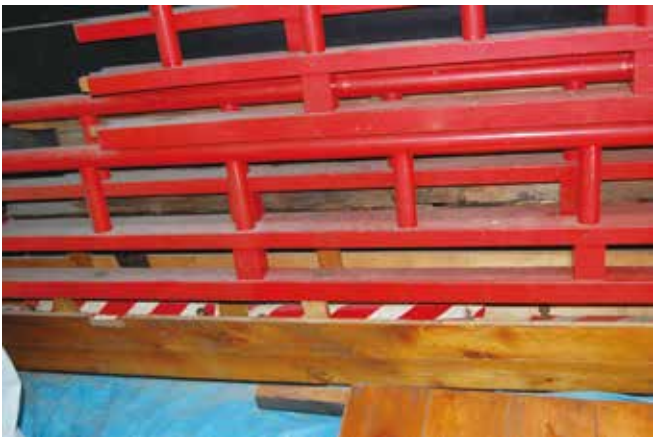
写真 3-28 湧玉神立（解体格納） 昭和 22 年建造旧屋台
