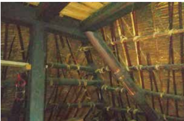
写真 3-27 屋根裏の茅葺きの構造（東南）
