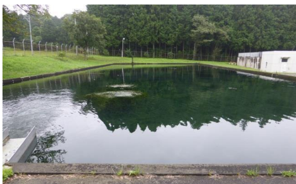
図 3-7 上井出浄水場（沈砂池）
