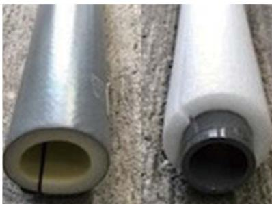
地表に出ている水道管を発砲スチロールなどの断熱材で覆い、凍結による水道管の破損を防ぎましょう。
