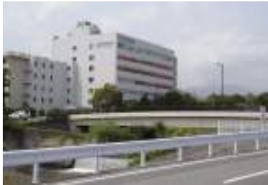
潤井川沿いの工場
