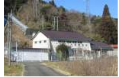
芝川沿いの発電所
