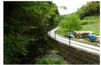
南沢ホテルのせせらぎ広場
