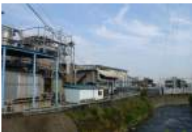
潤井川沿いの工場
