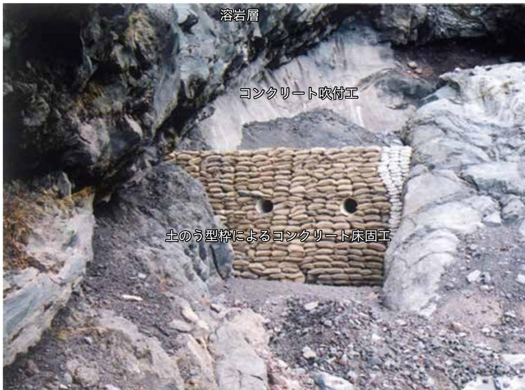
写真 2-4 溶岩層の崩落とスコリア層の侵食を防止する滝保護工
