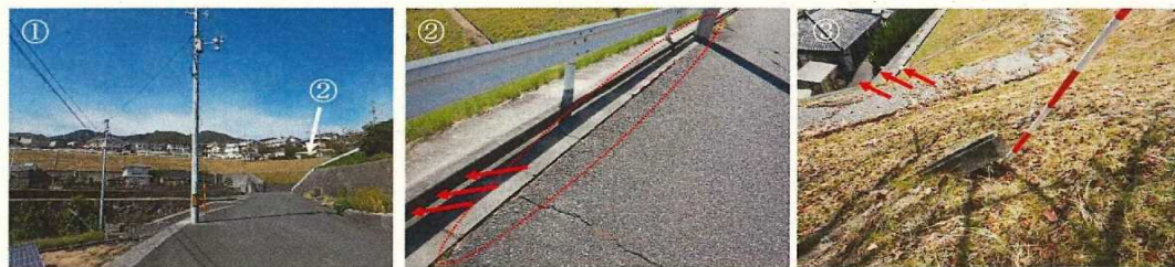
①のり面全景
