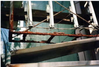
↑看板底部の脱落
